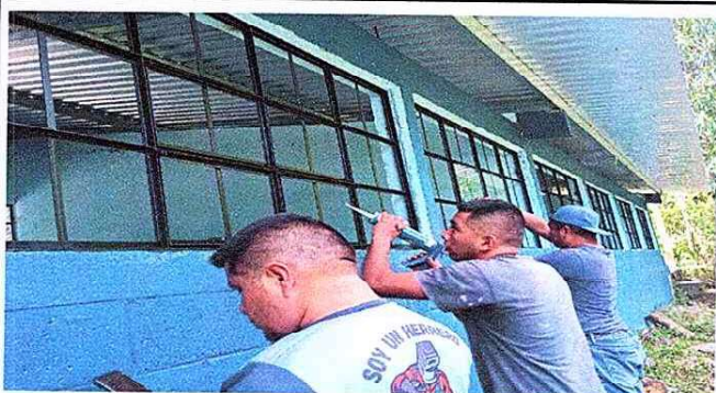
Foto 3: Sustrucion de la estructura de metal de vidrios
