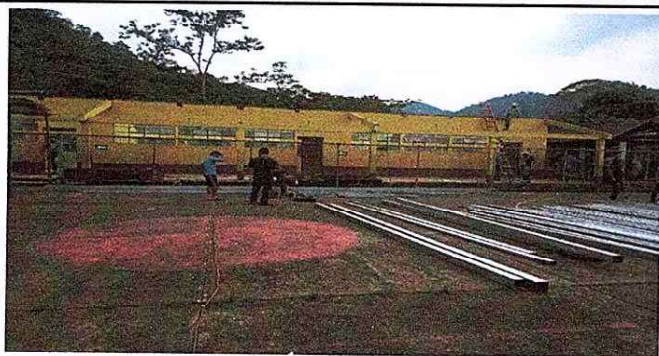
Foto1: Sustrucion de laminas en mal estado
