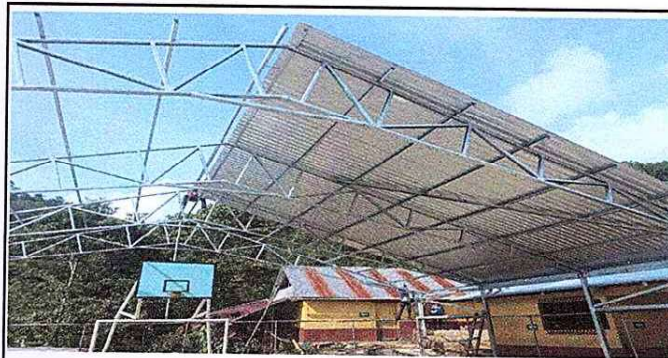
Foto 4: sustrucion de estructura metalica de entchado en cancha
