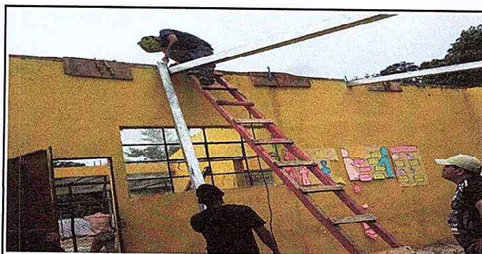
Foto 5: Sustrucion de costaneras a unas de metal
